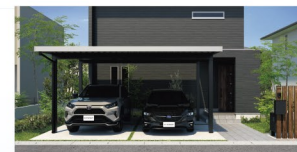
エクステリア工事
